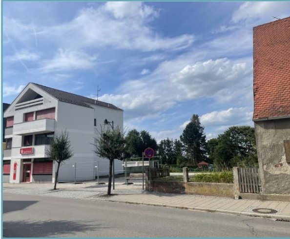
95. Abb. Liegenschaft neben der Sparkasse nach Rückbau
